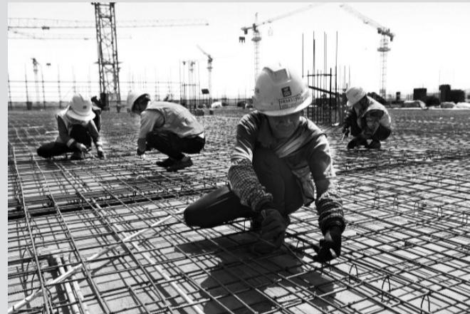
5月3日,由中建五局三公司承建的湖南大学科创港校区建设项目一标段现场,工人在绑扎钢筋。该项目是我省高等教育基础设施建设重点工程,一标段总建筑面积28.27万平方米,其中地下室建筑面积3万平方米。目前,地下室结构已顺利完工,全面冲出“正负零”,地上主体结构施工进入冲刺阶段。
