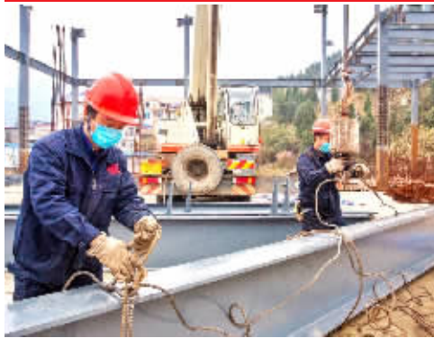
3月30日,花垣县芙蓉学校建设项目施工现场,大型吊装机正在紧张忙碌作业,工人们佩戴口罩,有条不紊推进项目建设。
