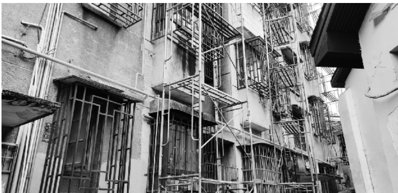
冶金机械厂宿舍天然气管道安装正在施工中。
