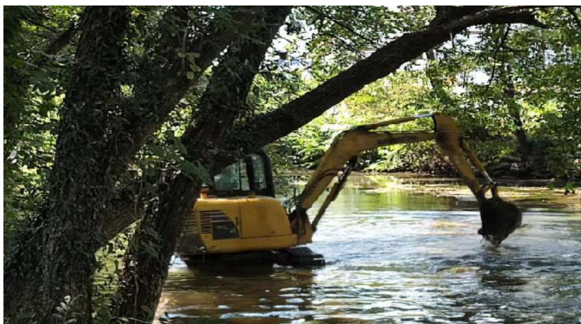
挖掘机对辖区内河库、小微水体进行清理。
