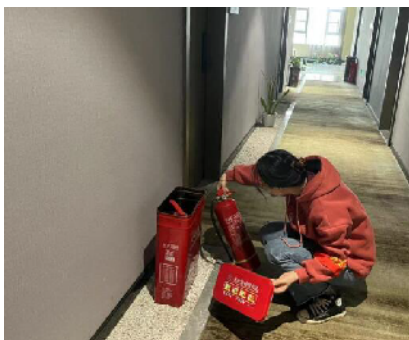
社区综治专干查看楼宇消防设施。
