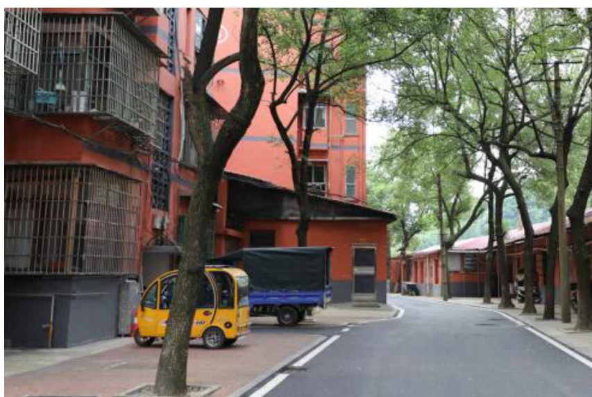
改造一新的氮肥厂小区。
