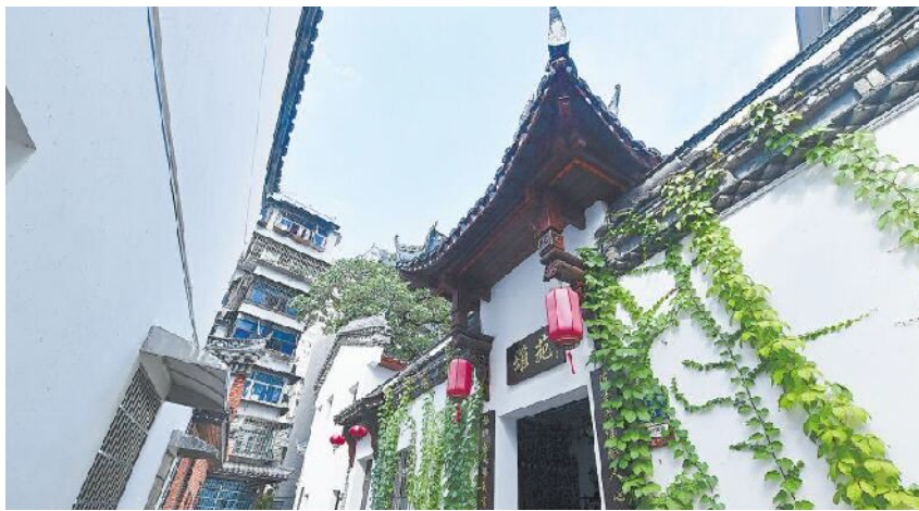
改造后的观音井巷 40 号公房焕然一新。
