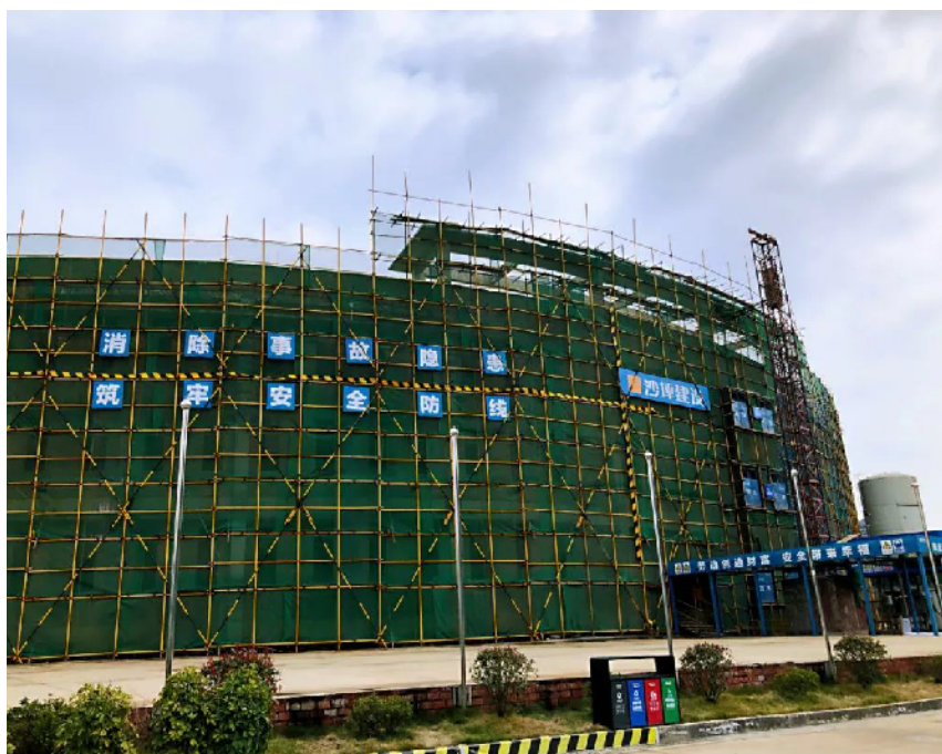
目前，长沙市儿童福利院项目南地块5、6、7号栋已封顶，南地块装饰装修正在着手进行中。
