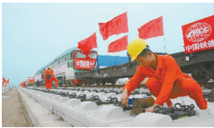
7月19日，中国铁建的施工人员正在铺轨机前作业。新华社发
