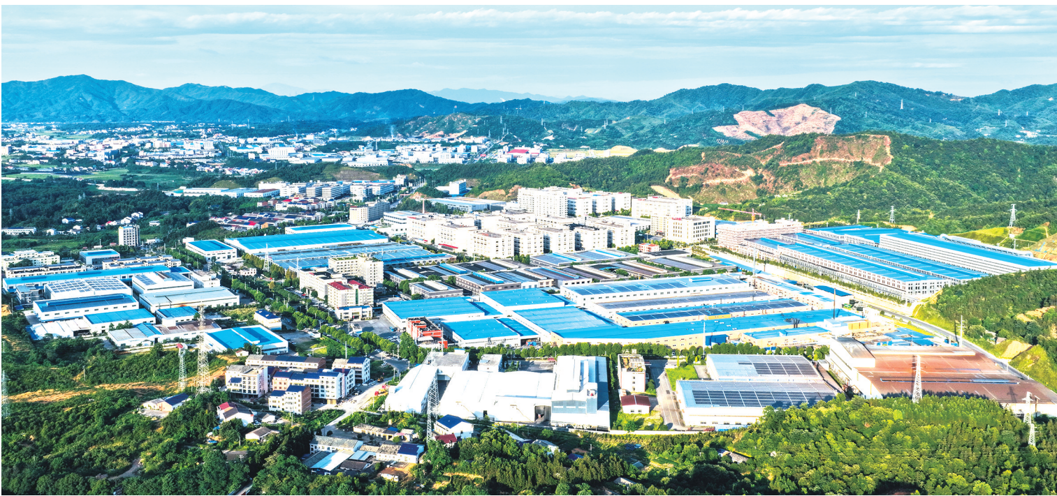
平江高新技术产业开发区伍市工业园区航拍图。
