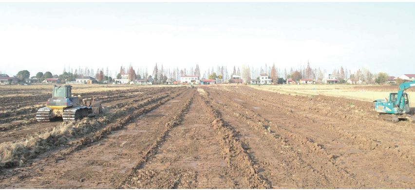
安乡县高标准农田建设现场。（本文图片均由安乡县融媒体中心提供）
