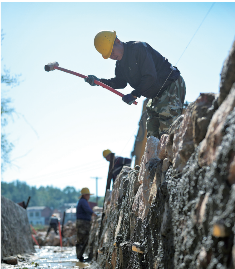
10月7日,双峰县井字镇白碧村高标准农田建设项目工地,工人正开展小河堤石砌护坡作业。入秋以来,该县统筹实施水利配套、田块整治、田间道路优化等工程,持续完善农业基础设施,提升耕地综合生产能力。 王乐君 李建新 摄影报道(湖南图片库)
