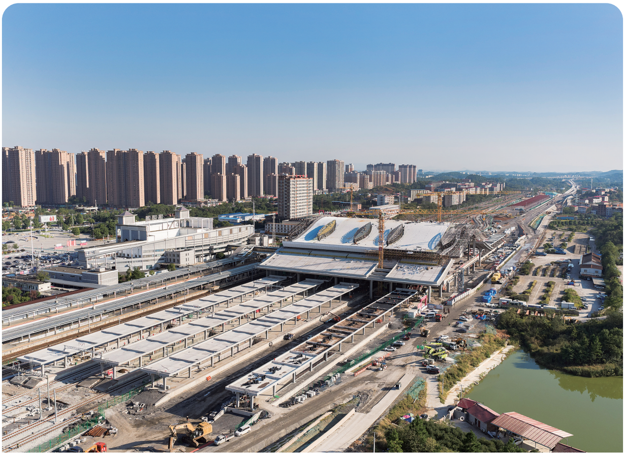
10月7日，邵永高铁永州站改造工程建设现场，中铁建设集团的工人正加紧施工。该工程是邵永高铁关键控制性项目，改造完成后，站台规模将由3台13线扩为6台18线，永州站将成为集湘桂线、益湛线、衡柳线、邵永高铁线、广清永高铁于一体的综合性交通枢纽，打通湘南地区对接粤港澳大湾区的高铁瓶颈。雷中祥 摄(湖南图片库)
