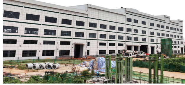
湖南华兴玻璃有限公司三期工程建设现场，厂房主体结构正有序推进。
