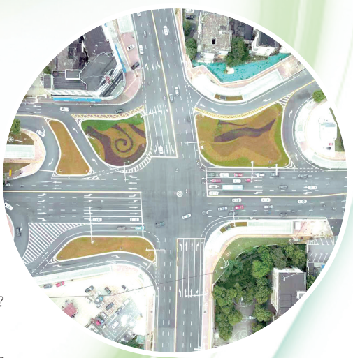
金花湖路平交改造后，切实畅通资阳城区核心片区。
