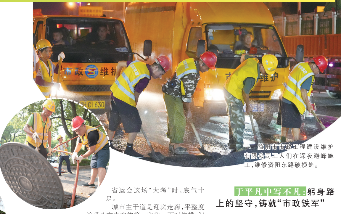
益阳市市政工程建设维护有限公司工人们在深夜避峰施工，维修资阳东路破损处。
