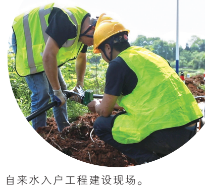
自来水入户工程建设现场。
