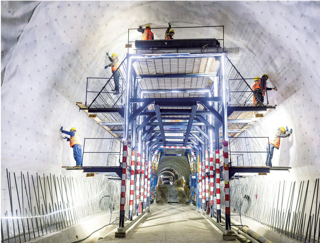
2026年2月13日，在吉尔吉斯斯坦贾拉拉巴德州，中国建设工人在中吉乌铁路贾拉拉巴德隧道施工作业。 新华社 发（任卫云 摄）
