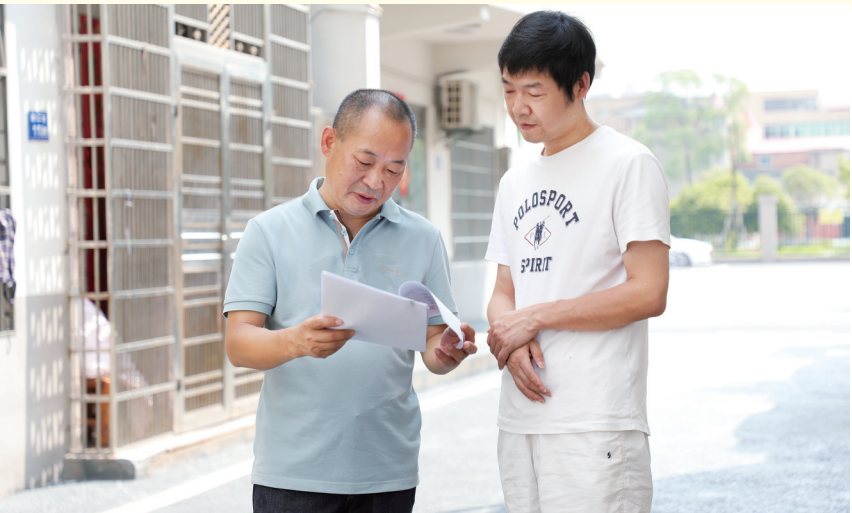
8月18日,王常红(左)和同事现场督导施工进度。 湖南日报全媒体记者 李杰 摄
