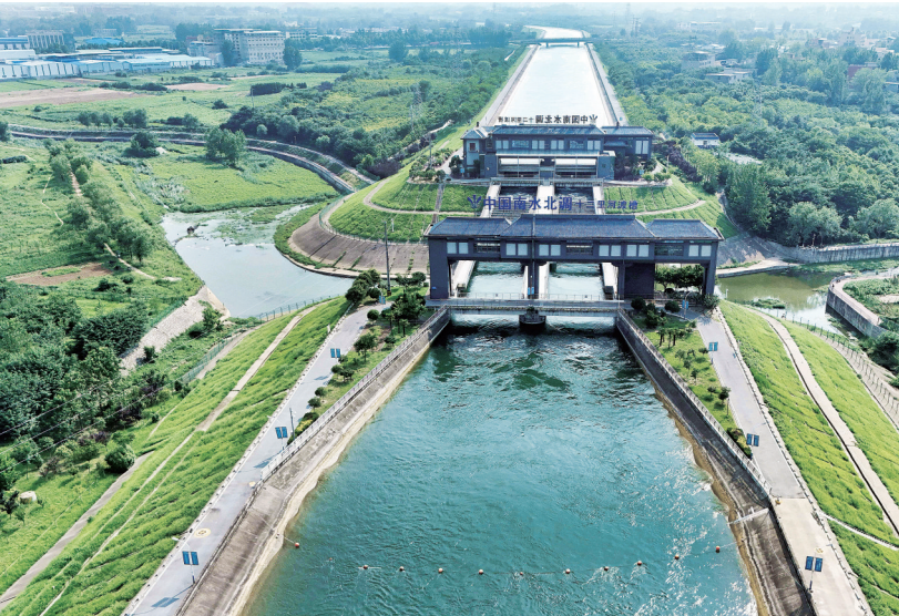
位于河南南阳的南水北调中线工程干渠十二里河渡槽（8月7日摄，无人机照片）。
