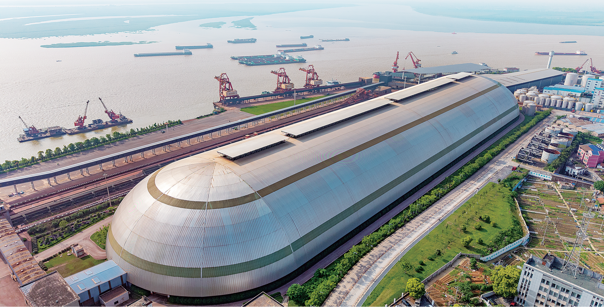
4月23日，岳阳市城陵矶港一派繁忙。该港作为湖南通江达海的“桥头堡”，近年来完成环保提质改造，“胶囊”式封闭料仓实现散货作业全流程抑尘，推动港口能级跃升。
