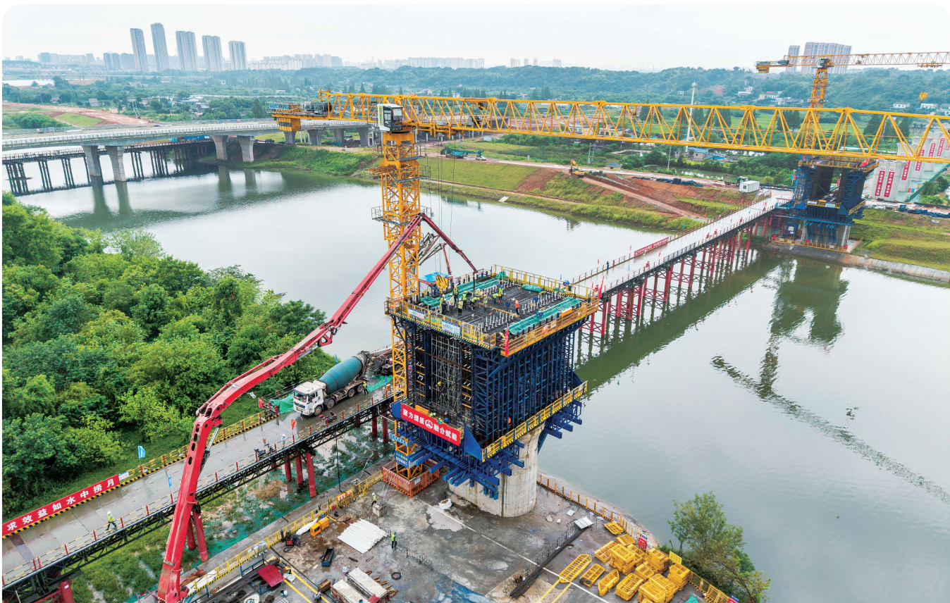
8月5日,由中铁五局承建的长赣高铁捞刀河特大桥首个连续梁0号块顺利完成混凝土浇筑,标志着该桥主体建设全面进入上部结构施工阶段,为项目快速推进打下坚实基础。捞刀河特大桥位于长沙县安沙镇,全长2539.63米。据了解,长赣高铁是国家“八纵八横”高速铁路网中渝厦通道的重要组成部分,线路从湖南长沙引出,终至江西赣州,新建正线全长约429公里。 新华社记者 陈思汗 摄
