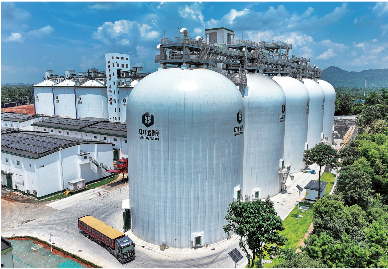
7月24日,我国首批9000吨级气膜粮仓在中储粮长沙直属库建成后进行首次装粮压仓作业,这意味着我国第四代新型粮仓正式进入应用新阶段。
