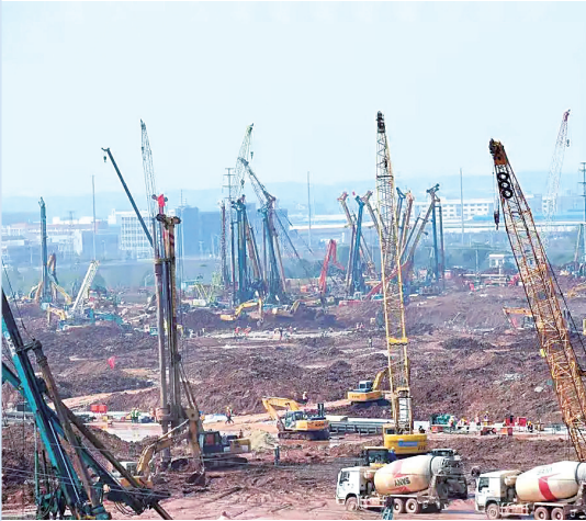
2019年，全国最大单体面板类高科技厂房——长沙惠科第8.6代面板生产线项目建设现场。 通讯员 摄
