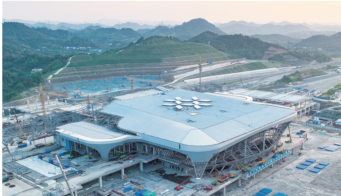
6月15日傍晚,长沙高铁西站建设工地一派繁忙。作为国家“八纵八横”高铁网渝长厦通道的关键节点,该项目整体工程量已完成过半,“杜鹃花开”造型的站房初具雏形。项目预计于2027年底建成,届时长沙将正式迈入“双高铁枢纽”时代。 江毅 摄(湖南图片库)
