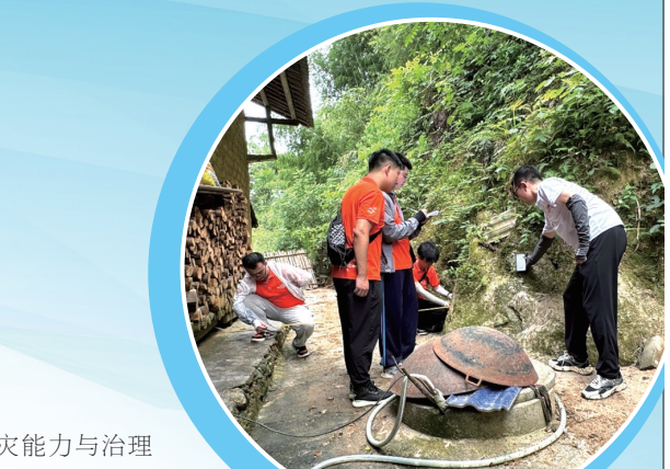
土木移动诊所:民房边坡检测志愿服务。
