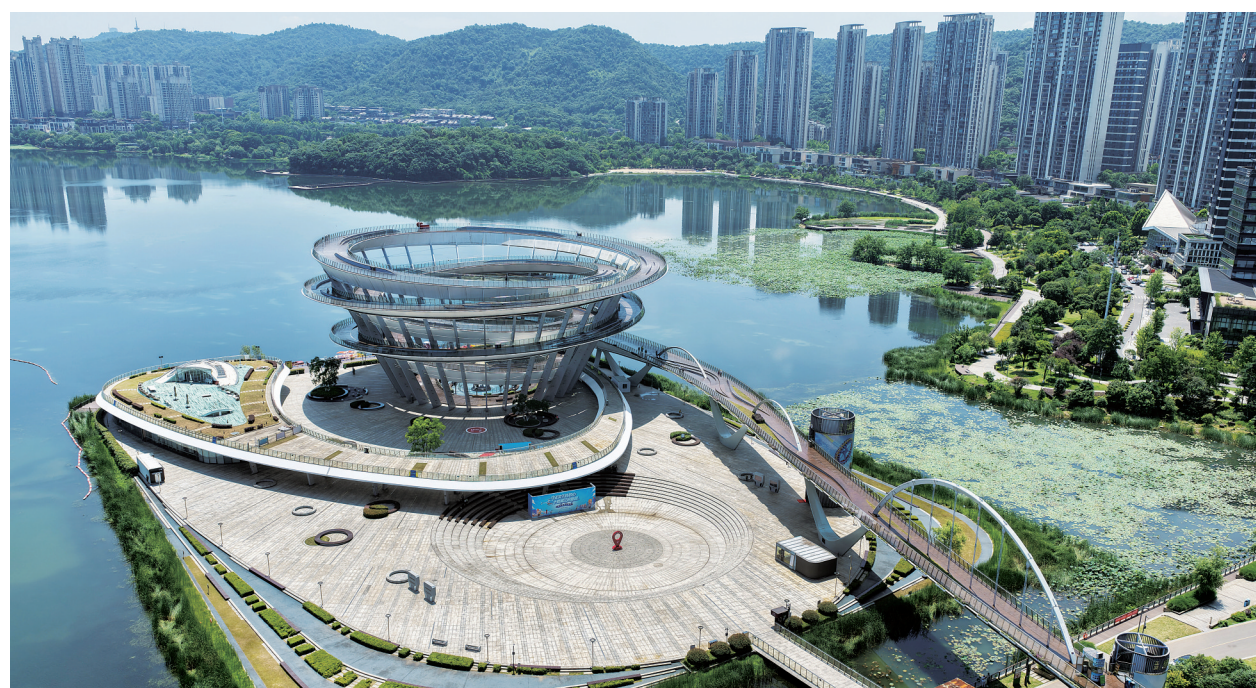
6月10日，提质升级后的湖南湘江新区梅溪湖城市岛重新开放迎客。自5月25日起，该岛重点对螺旋木栈道、广场铺装进行了全面翻新，并对设施进行了维修加固，以崭新面貌迎接游客。 湖南日报全媒体记者 田超 摄
