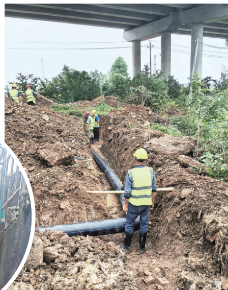
湘阴县纪委监委督导鹤龙湖管网延伸项目施工。刘建国 摄
