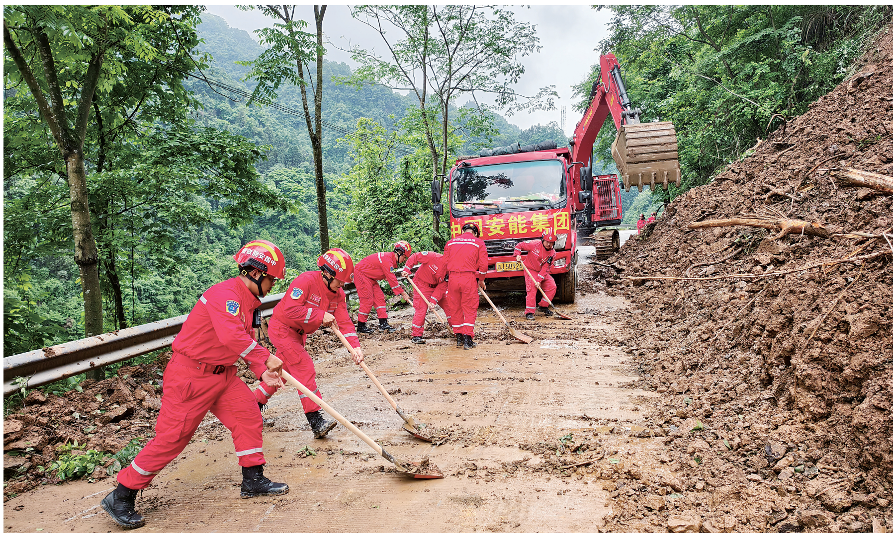
5月25日，省道S522石门县壶瓶山至东山峰段K5+550处，中国安能救援队伍在清理道路淤泥。
