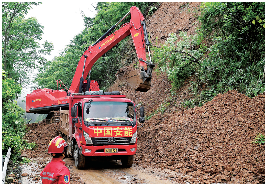
5月25日，中国安能救援队伍在清除山体滑坡。24日，大雨导致省道S522石门县壶瓶山至东山峰段K5+450处山体滑坡，造成交通中断，中国安能救援队伍第一时间调派大型设备抢险。
