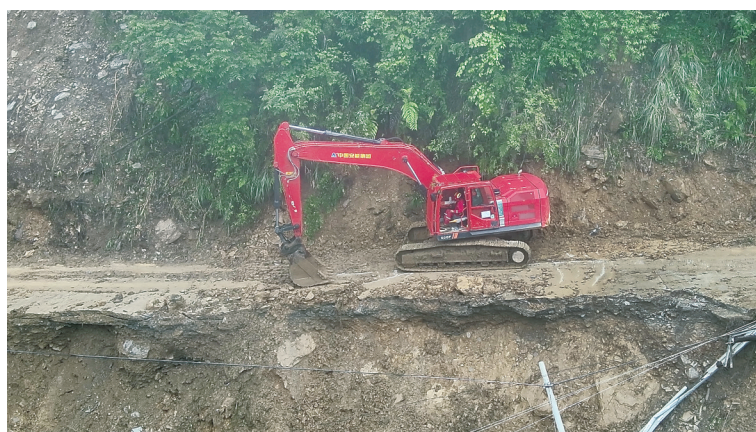
5月27日，石门县南北镇Y075路段滑坡区域，中国安能救援队员操作挖掘机对滑坡体进行清理。
