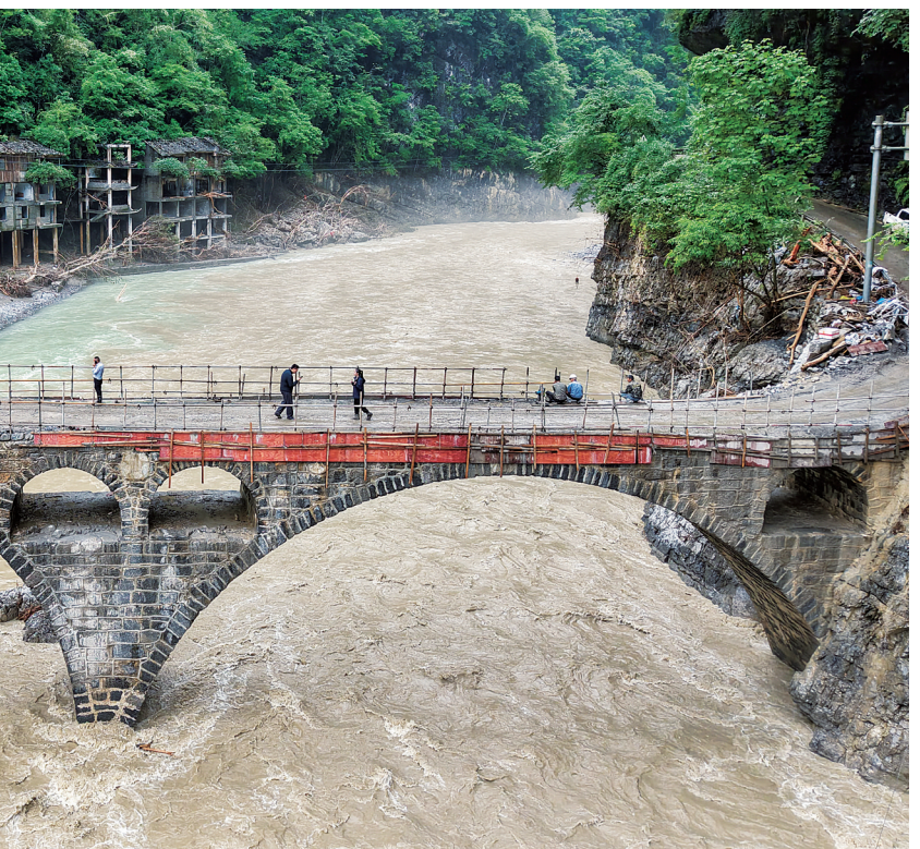
5月27日,经过24小时连续奋战,石门县壶瓶山镇神泉寨桥被冲垮的桥面完成抢修,恢复通行。该桥在5月18日的特大暴雨中被洪水冲垮桥面,导致北溪河、大岭等7个村通往集镇的唯一通道中断。随着这条“生命线”的打通,壶瓶山镇受灾区域物资供应及生活保障通道已全面恢复。
