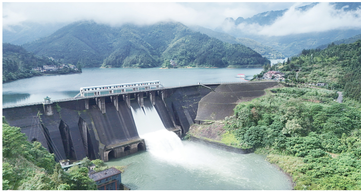
5月22日，江永县源口水库正在开闸泄洪腾库。连日来，受强降雨和上游来水影响，该县境内河流、水库水位持续上涨。源口水库精准监测，科学调度，适时开闸泄洪，有效缓解防洪压力。田如端 摄（湖南图片库）
