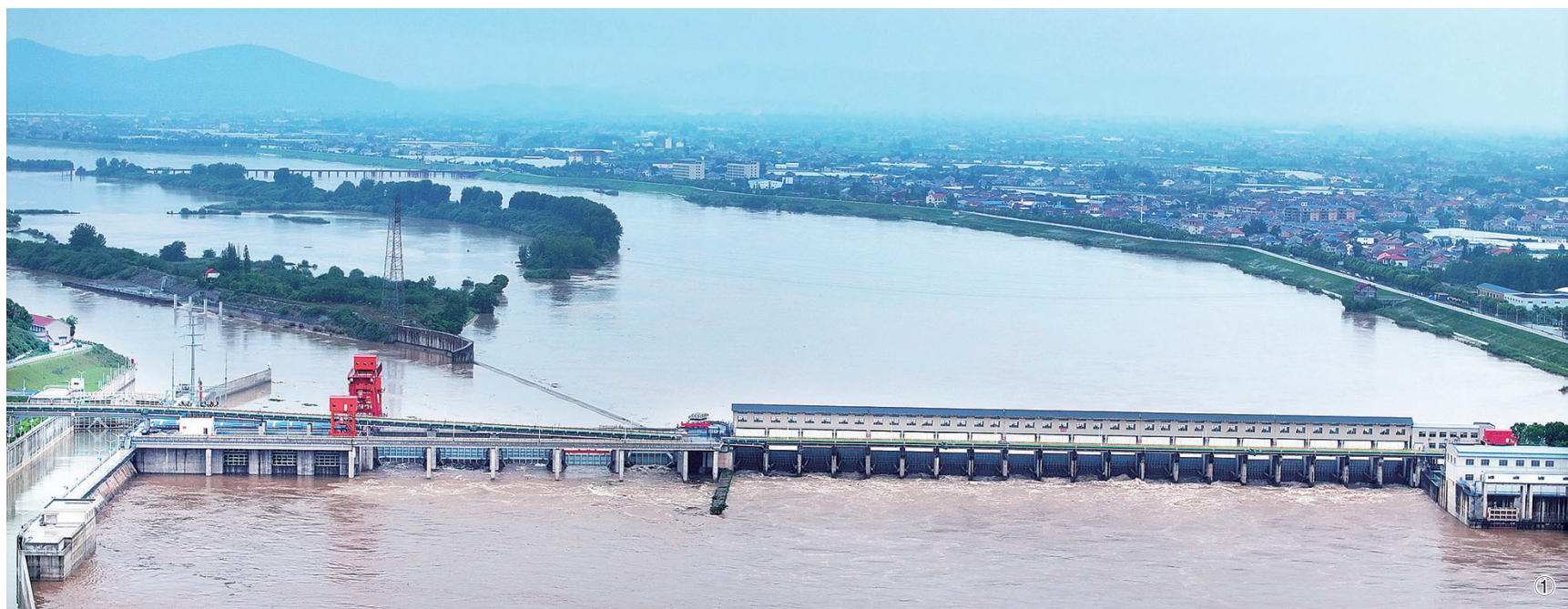
图①:5月19日,澧县涇州电站大坝开闸泄洪。自18日凌晨起,澧县涇州电站25孔泄洪闸全部开启,以不低于4500立方米/秒的流量泄洪。这是该电站今年首次全面开闸泄洪,也是澧水航道涇州枢纽船闸配套建成5孔泄洪闸后首次开闸泄洪。
