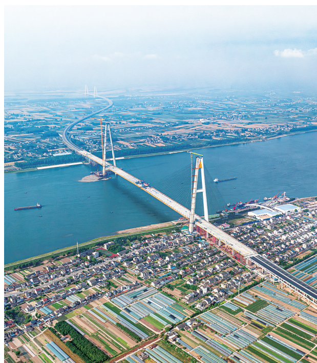
5月15日，枝江长江大桥最后一根钢梁精准落位，这座“世界级”斜拉桥在江心完成最后“牵手”，标志着大桥顺利合龙，为2026年下半年项目建成通车奠定了重要基础。图为当日拍摄的枝江长江大桥施工现场(无人机照片)。
