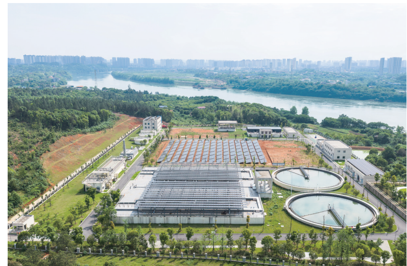
5月9日，永州市冷水滩区永州市河东污水处理厂，光伏板正源源不断输送绿色能源。近年来，当地持续推进“光伏+”多元融合模式创新，利用厂区屋顶、空旷场地、乡村山地等闲置空间建设分布式光伏发电项目，实现绿色转型与经济效益双赢。雷中祥 摄(湖南图片库)
