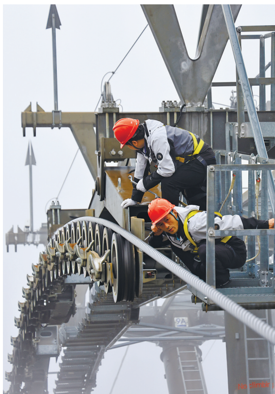
4月29日，张家界国家森林公园天子山索道工作人员高空作业，对索道运行设施进行检查维护。“五一”假期来临，该景区加强客运索道日常巡检和维护保养，保障假期旅游安全。 吴勇兵 摄(湖南图片库)
