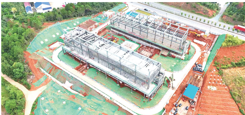
江背变电站基础施工。
