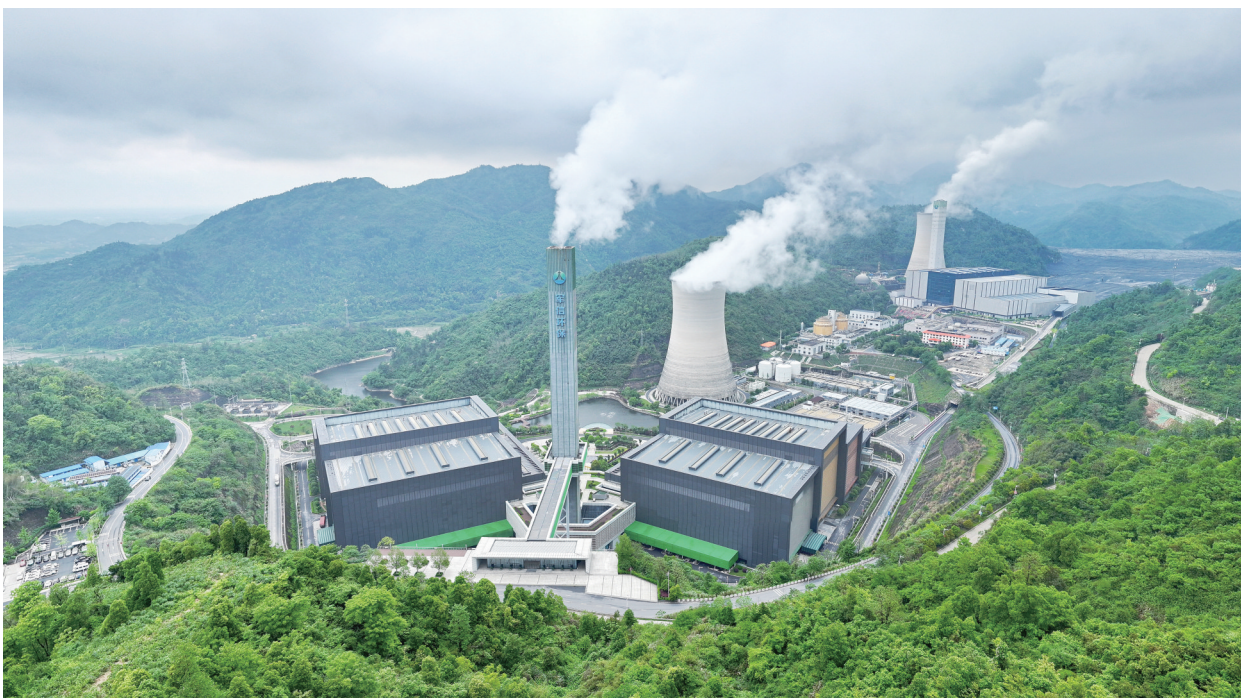
4月22日，位于湖南省长沙市望城区东北角黑麋峰下的军信股份黑麋峰环保园区。这个大型综合环保产业园承担着长沙市六区一县生活垃圾及大部分市政污泥的处理。通过构建“固废综合协同处理+绿色能源”模式，园区日生活垃圾（入场垃圾）处理能力达一万吨、污泥一万吨。通过垃圾焚烧发电，园区年产生绿电超17亿度，可满足长沙居民十分之一的生活用电，二氧化碳年减排量超120万吨，为长沙“无废城市”建设与绿色低碳发展注入强劲动能（无人机照片）。
