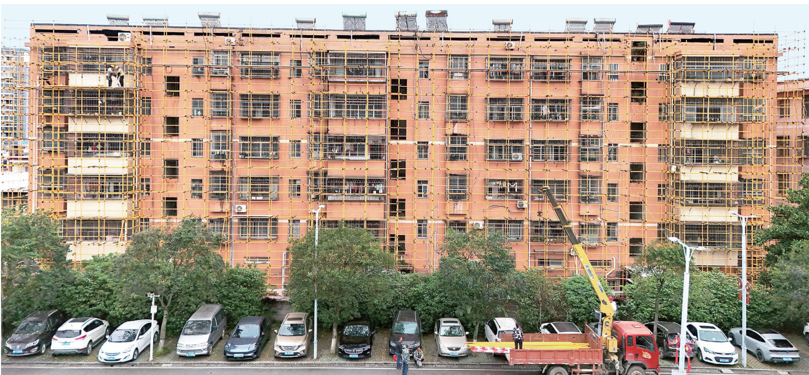
改造老旧小区 4月7日，江永县一老旧小区改造现场，工人正在进行小区外立面施工。近年来，该县通过加装电梯、提升照明、优化环境等措施，全面提升多个老旧小区基础设施，切实改善居民生活环境。田如瑞 摄(湖南图片库)
