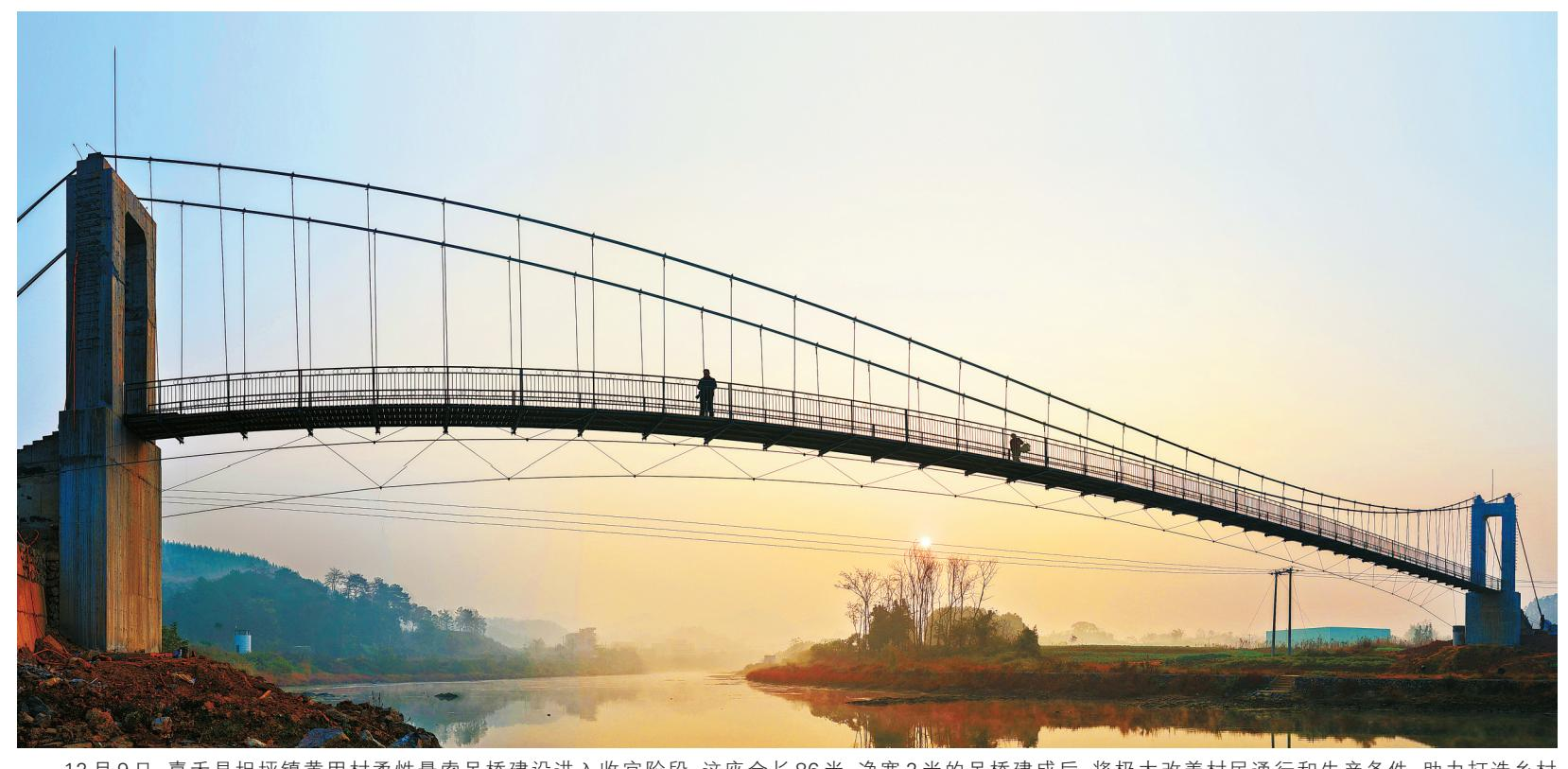
12月9日,嘉禾县坦坪镇黄甲村柔性悬索吊桥建设进入收官阶段。这座全长86米、净宽2米的吊桥建成后,将极大改善村民通行和生产条件,助力打造乡村旅游新亮点。黄春涛 摄(湖南图片库)
