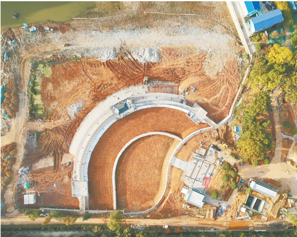
长沙红旗渠排水改造调蓄池竣工,项目正在进行园林绿化施工。
