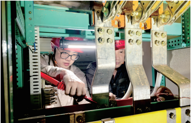
国网湖南电科院“电博士”团队在配电间开展低压开关柜送电前绝缘测试。
