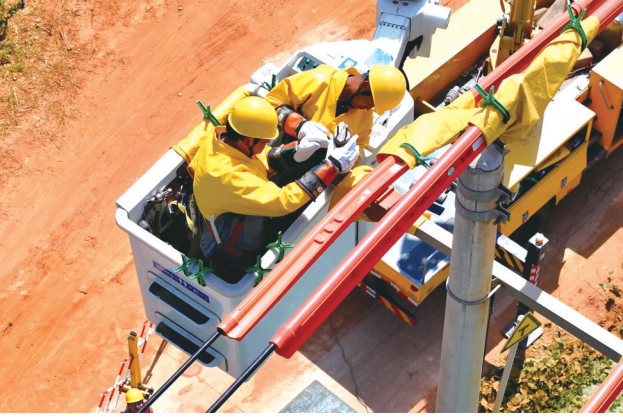
国网湘潭供电公司在省内率先成立配网应急响应中心。图为员工在湘潭市雨湖区10千伏响花线开展带电作业，快速消除线路瓷瓶隐患。周波 摄
