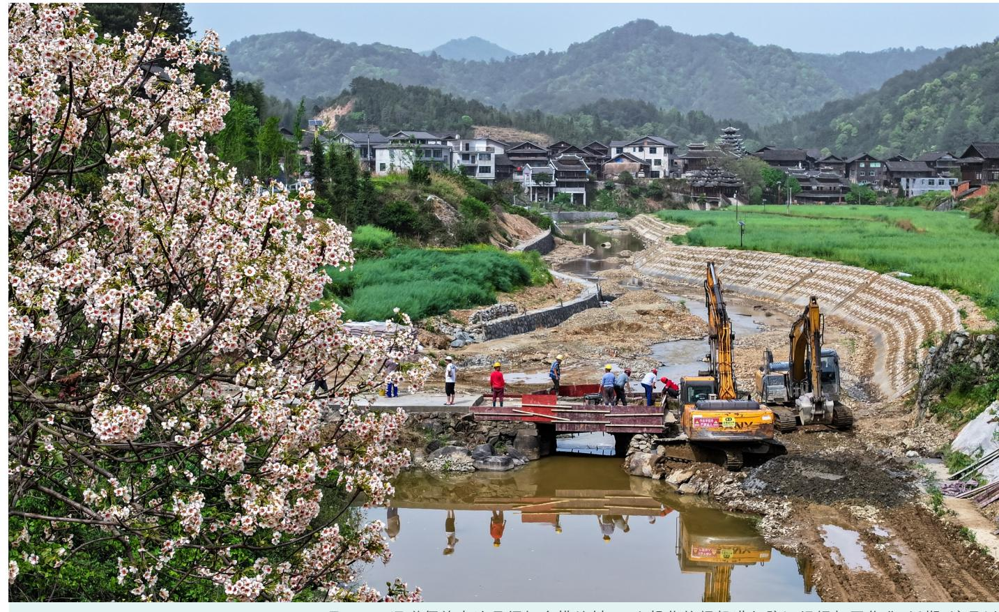
4月13日,通道侗族自治县坪坦乡横岭村,工人操作挖掘机进行防汛堤坝加固作业。近期,该县以提升河道防洪保安为抓手,通过实施河道清理、堤防加固、岸坡防护等工程作业,为农业生产提供水利保障。
