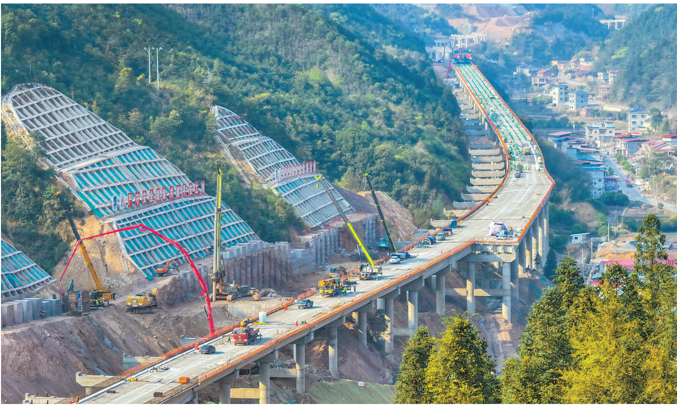
4月1日，双牌县零(陵)道(县)高速公路项目现场，工人在施工作业。连日来，零道高速公路建设者们全力抢抓工期，有序推进项目建设。该项目建成通车后，将形成呼北高速粤港澳大湾区支线，打通永州市向南接广西、广东通道。 蒋克青 袁程 摄影报道(湖南图片库)
