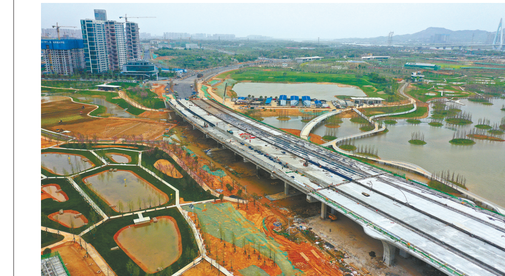
3月28日,长沙市望城区大泽湖近自然湿地公园环湖路项目现场,高架桥钢箱梁桥面吊装焊接已基本完成,施工人员进行桥面施工。项目建成后,可有效串联大泽湖南片、北片路网,同时方便市民进出公园休闲娱乐。
