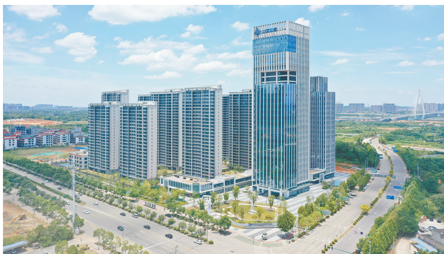
7月17日，位于长沙大泽湖片区的中交湘江总部中心项目建成交付。这是大泽湖·海归小镇的首个标志性项目，集总部办公、生态居住、品质商业于一体。该项目将助力聚集当地智能化核心产业优势，推动片区数字化、网络化、智能化产业发展。
