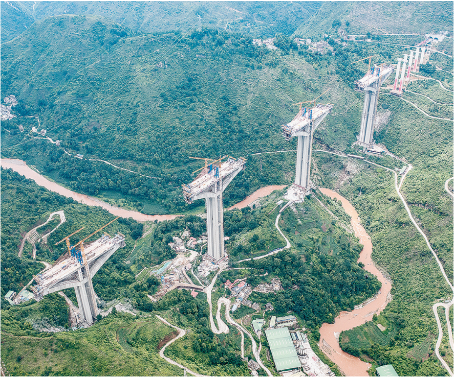
6月17日,随着六枝特大桥8、9号主墩空腹区交会,纳晴高速六枝特大桥全桥上下弦全部完成“交会对接”,即将转入“刚构桥”施工阶段,大桥建设取得了阶段性胜利。六枝特大桥位于贵州省六盘水市六枝特区中寨乡境内,是纳雍至晴隆高速公路的控制性工程,大桥全长2023.5米,桥面距谷底水面净空315米。这是建设中的六枝特大桥桥墩(无人机照片,6月17日摄)。
