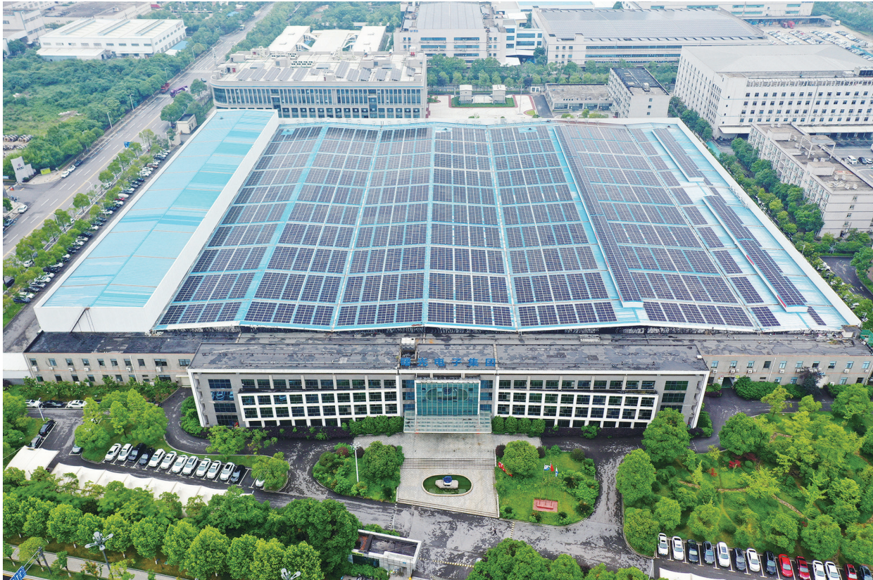
5月22日,曙光电子集团首个分布式光伏电站项目已基本完工。该项目是利用现有机械厂房36000平方米闲置屋顶建设4.2MW分布式光伏电站。项目建成后,曙光集团用电将实现自发自用、余电上网,大大降低用电成本。
