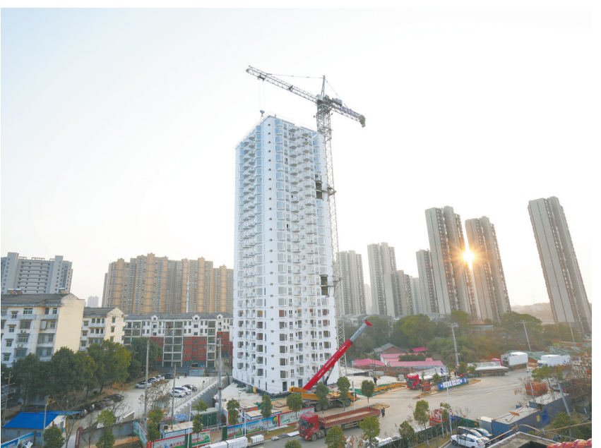
图为全球首座高层活楼高级住宅(白色建筑)。
