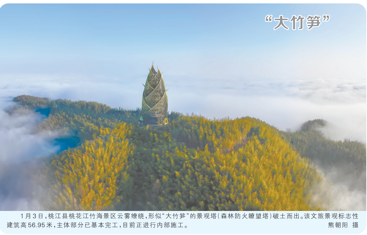
1月3日,桃江县桃花江竹海景区云雾缭绕,形似“大竹笋”的景观塔(森林防火瞭望塔)破土而出。该文景观标志性建筑高56.95米,主体部分已基本完工,目前正进行内部施工。 熊朝阳 摄
