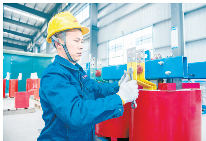
12月20日,娄底经开区湖南乐立保电气有限公司,工作人员在组装输变电产品。临近年末,娄底经开区内各企业开足马力忙生产,确保实现全年目标。 吴永华 摄
